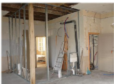
En attendant, l'été est arrivé tranquillement, et Loïc qui était en congé parental a pu bien avancer sur le chantier de la future maison. Les fenêtres et volets roulants sont posés, les cloisons intérieures finies, l'isolation faite, le plafond renforcé... puis il a attaqué le long et silencieux labeur de plomberie et d'électricité. Les avancées sont visiblement moins spectaculaires que jusque là, et pourtant,
